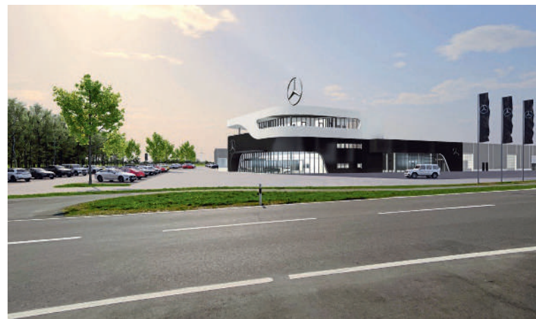
Futuristisches Design: Die geschwungene Fassade ist eine Hommage an die ikonischen Silberpfeile.
